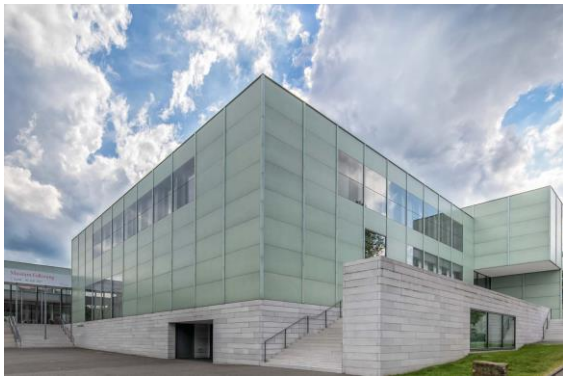
Museum Folkwang, Ansicht Chipperfield-Neubau
